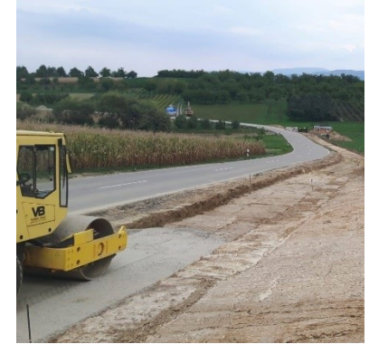
September: Der Ausbau geht weiter. Neuer Radweg wächst
