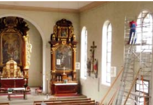
Ausbau des bisherigen Kirchenfensters
